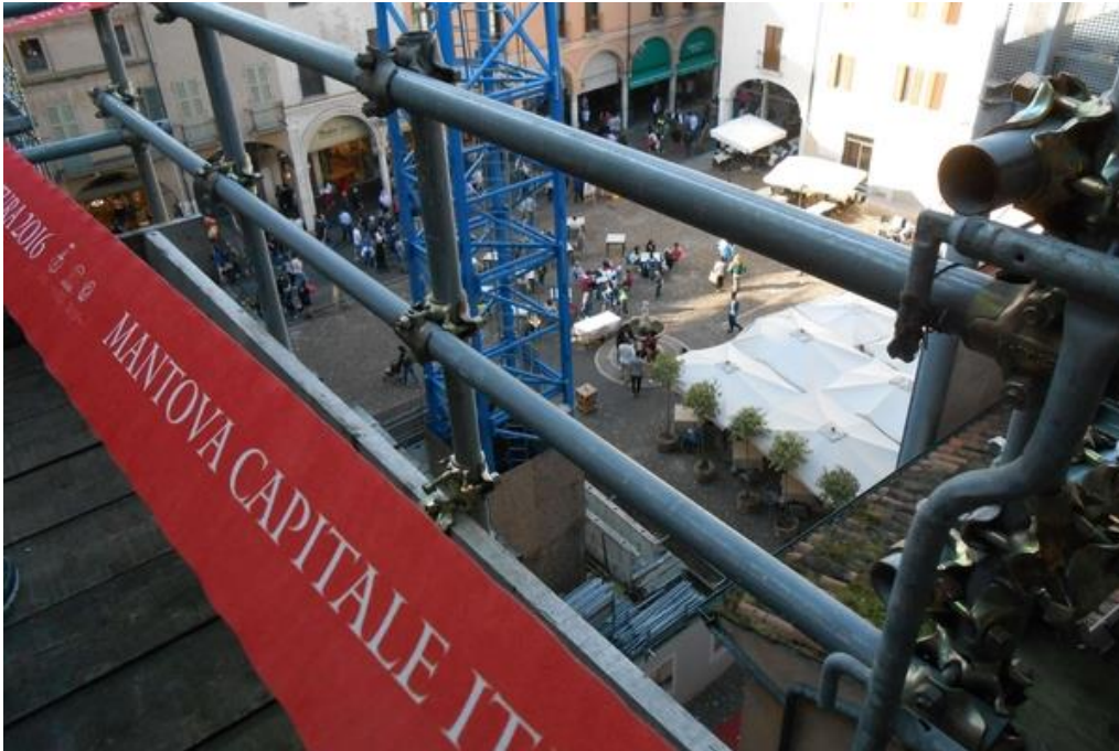
Il cantiere del Palazzo del Podestà aperto in via straordinaria
