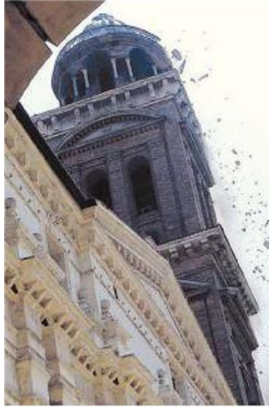
Il crollo del campanile di Santa Barbara
